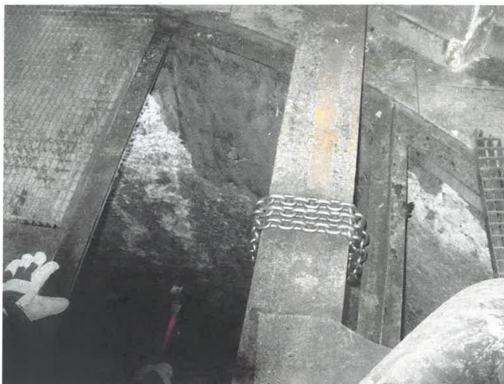
Zdjęcie 2. Widok na wnętrze zbiornika.
