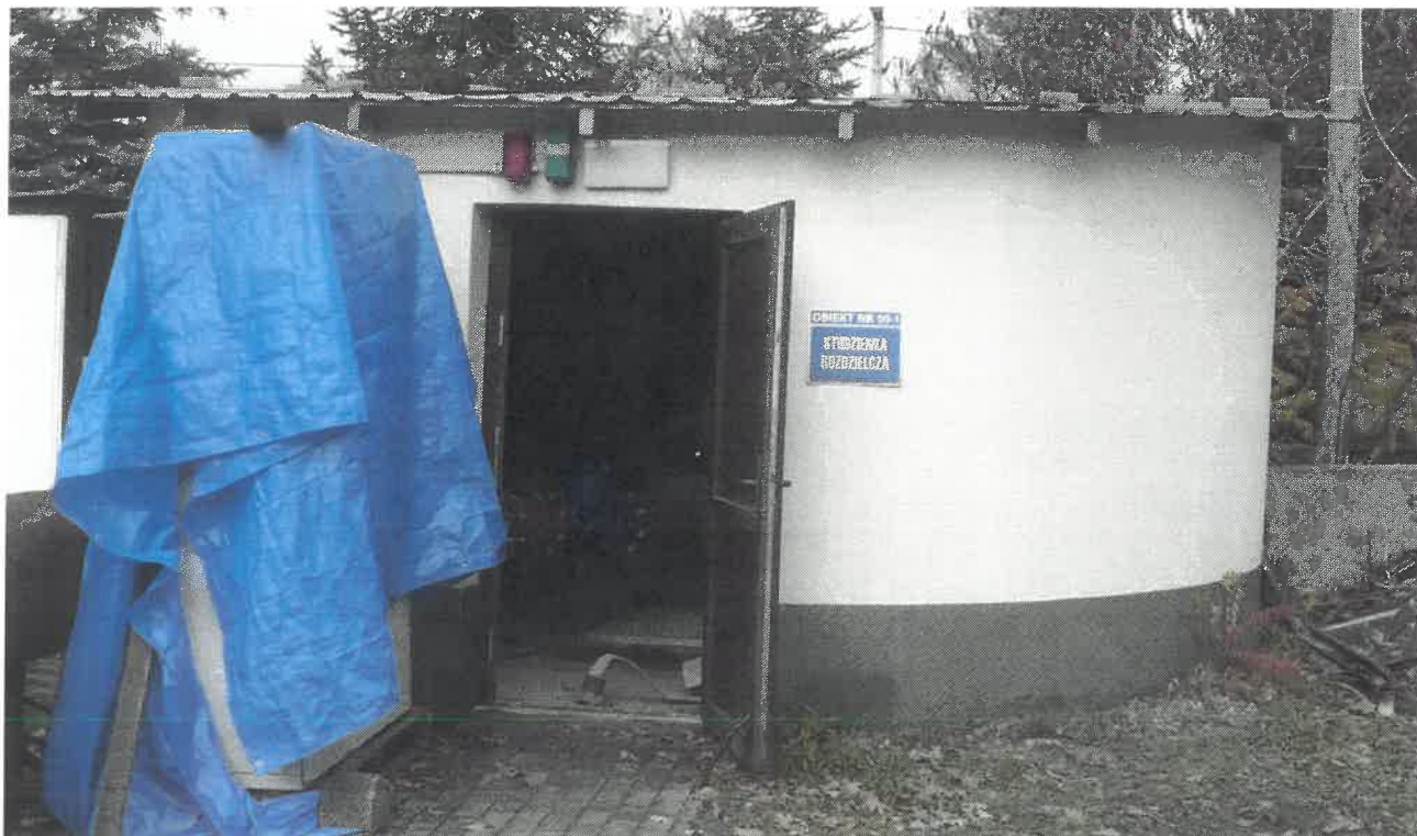
Zdjęcie 1. Elewacja wejściowa.
