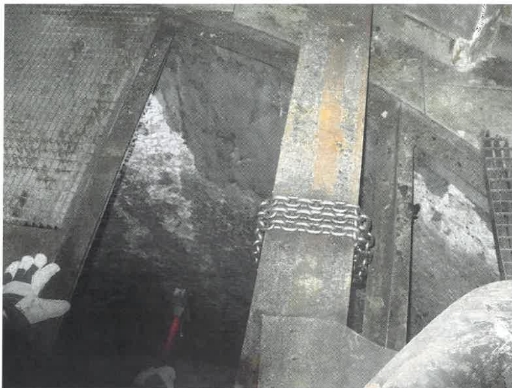
Zdjęcie 2. Widok na wnętrze zbiornika.
