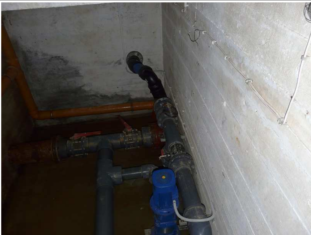
24. Komora techniczna - ściany i dno.
