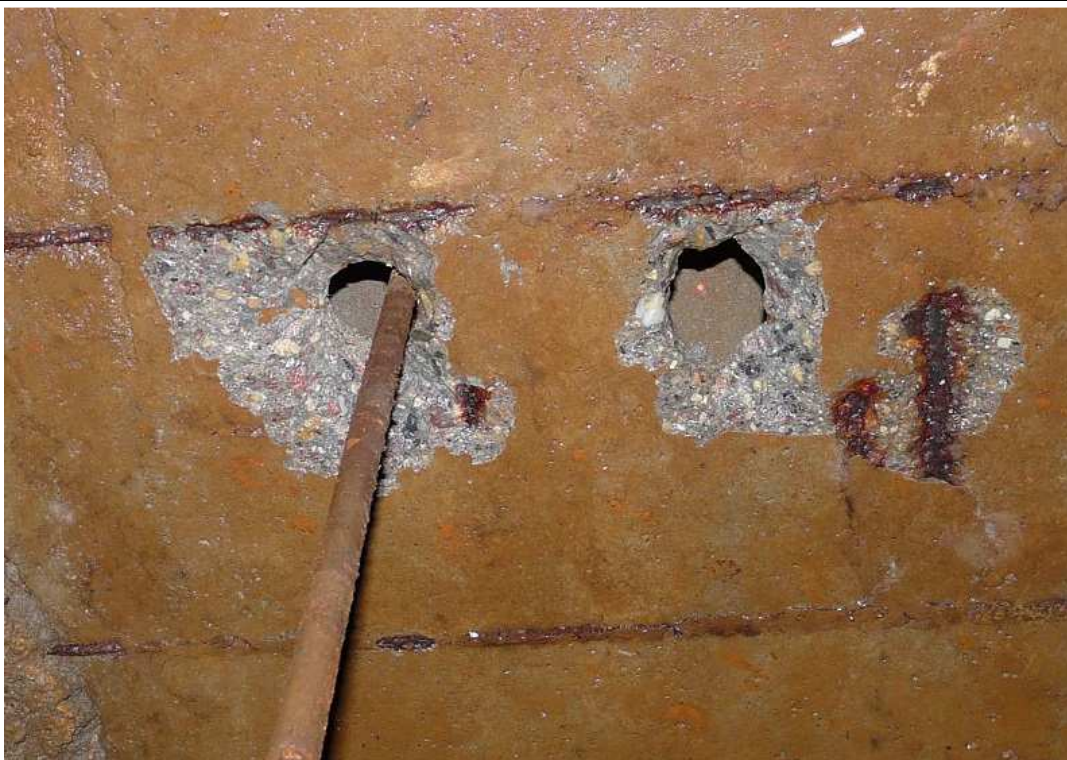
18. Komora nr2 - otwory w płycie kanałowej.
