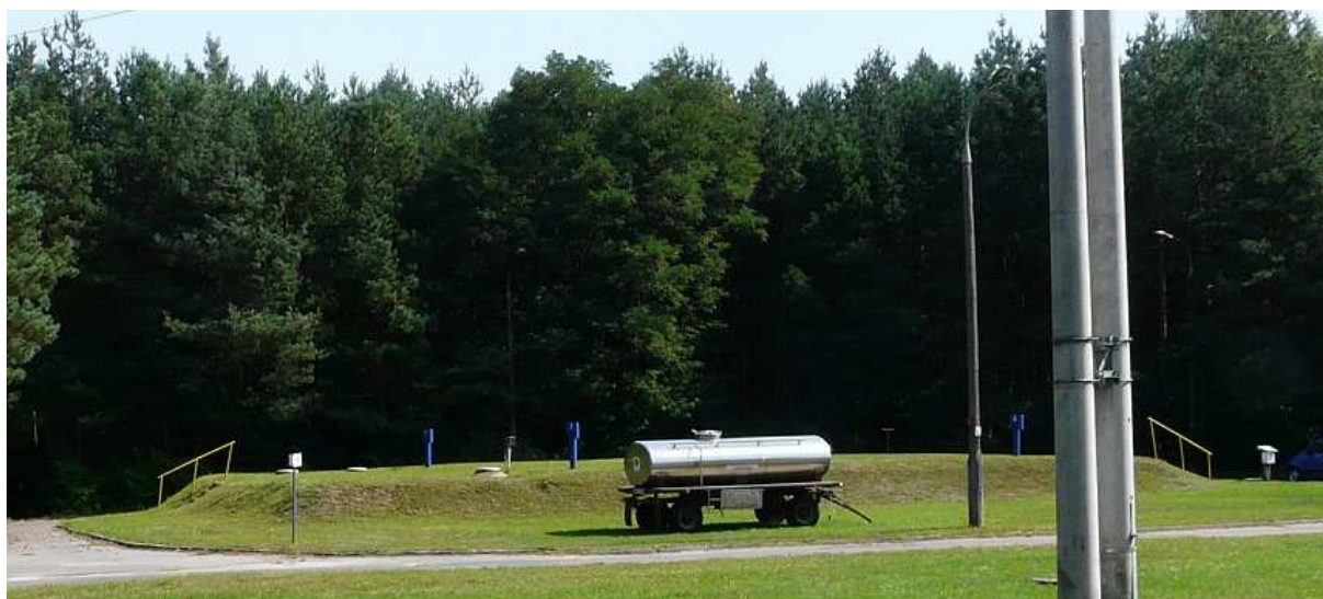
1. Zdjęcie ogólne zbiornika od strony zachodniej.
