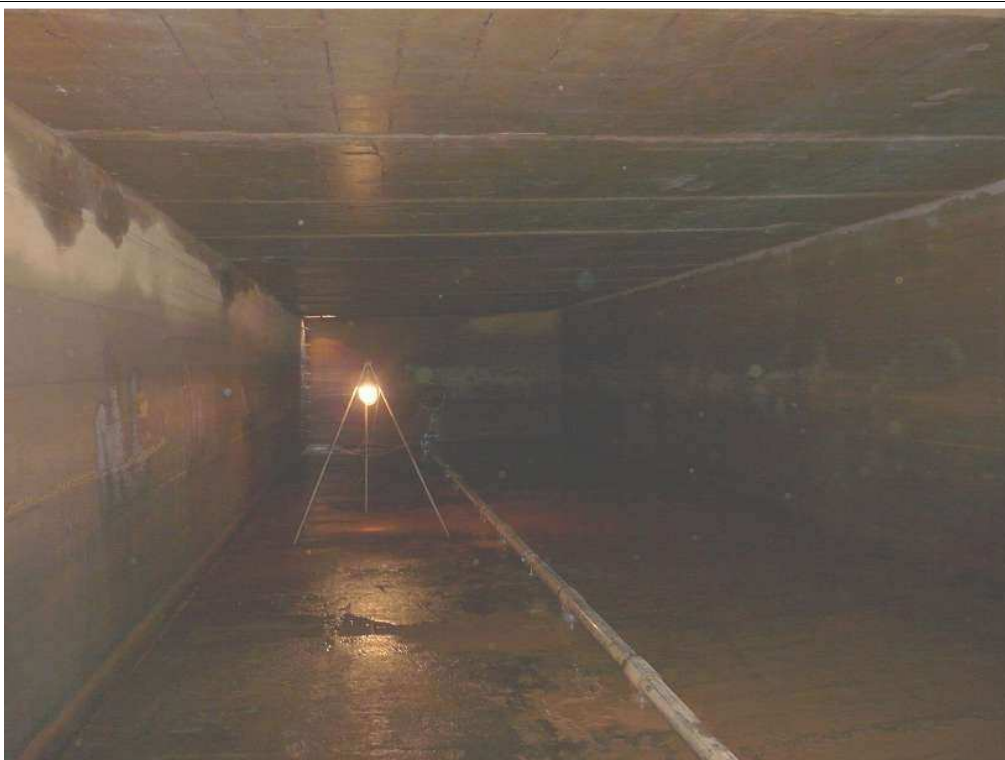
11. Komora nr2 - widok ogólny w kierunku południowym.
