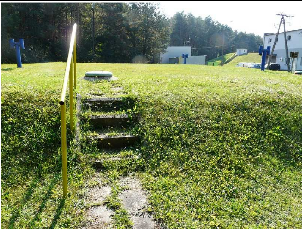
3. Schodu wejściowe na zbiornik od strony północnej.
