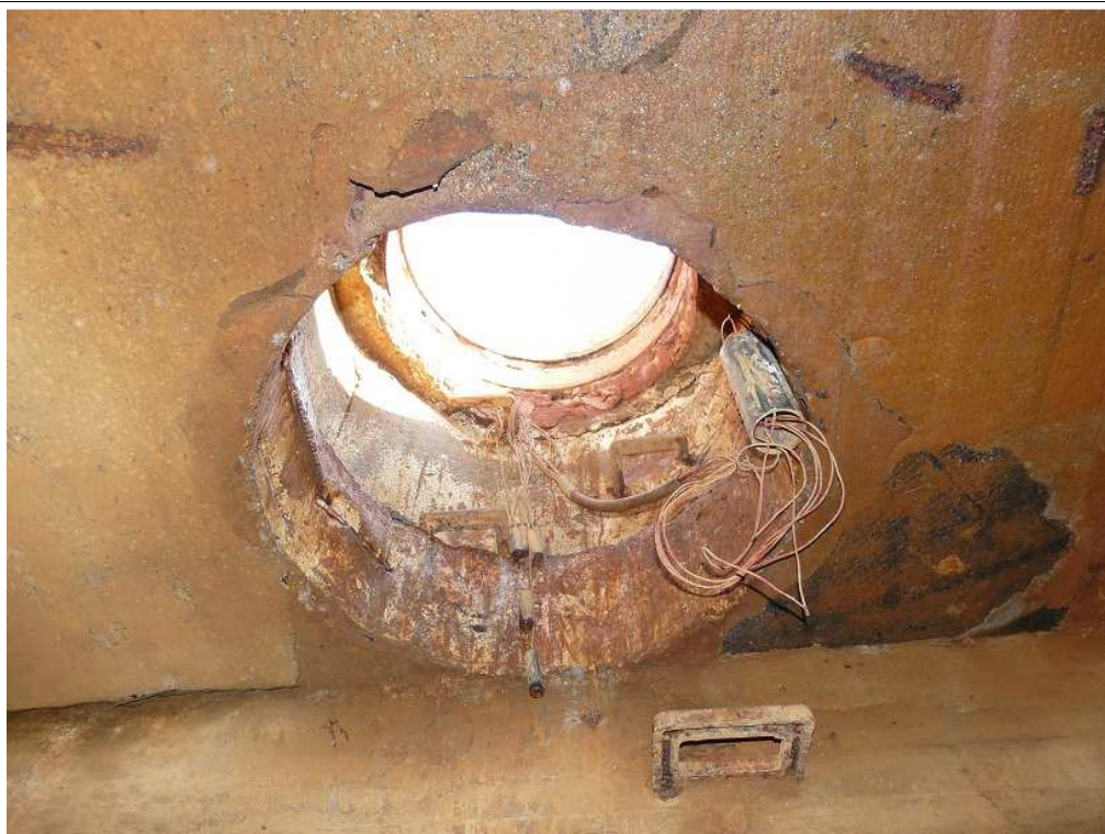
13. Komora nr2 - wejście do komory od strony północnej.
