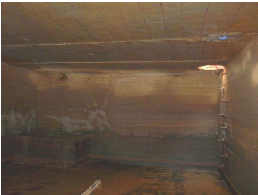
12. Komora nr2 - widok ogólny w kierunku północnym.
