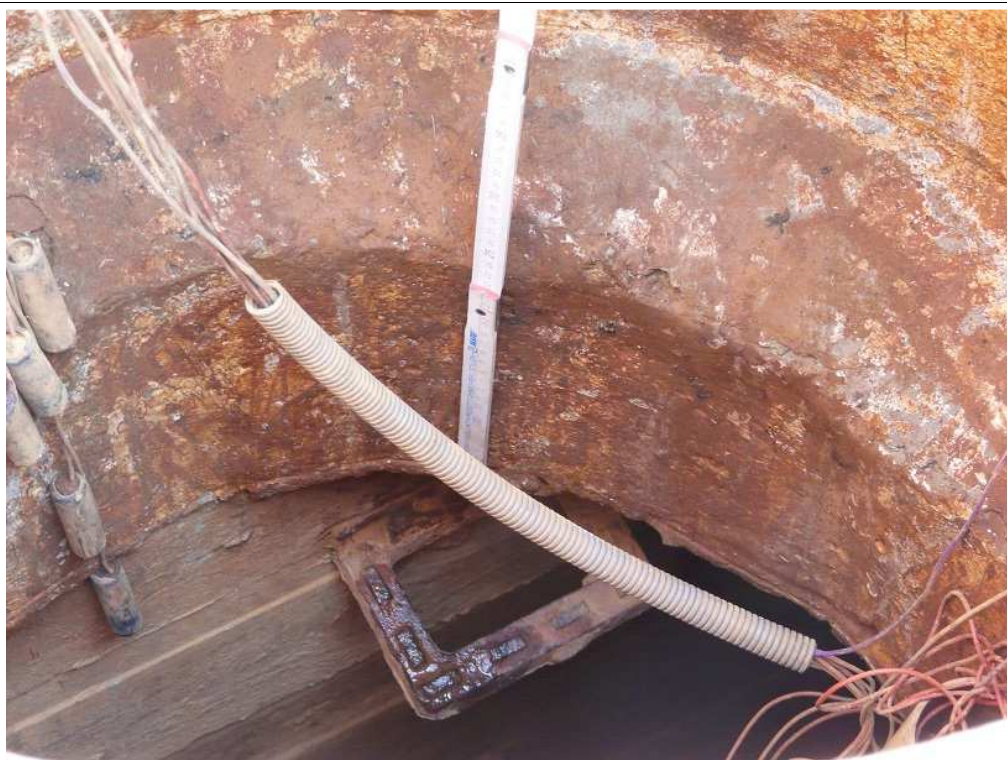
6. Kominiek wejściowy do komory nr2 - część dolna.
