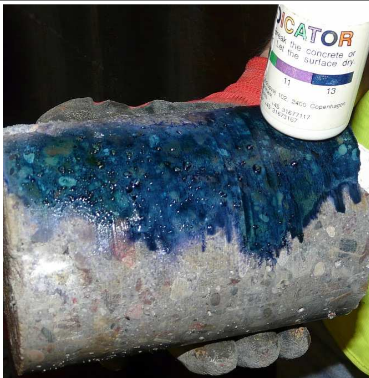
21. Komora nr2 - badanie odczynu betonu z odwiertu.
