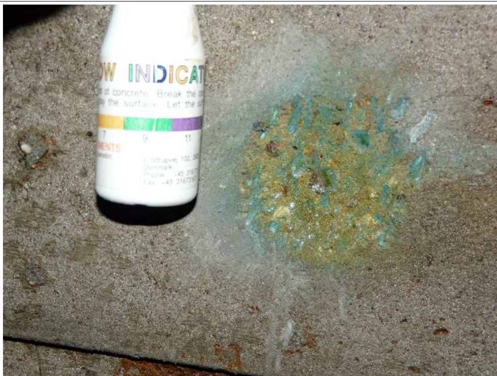
22. Komora nr2 - badanie odczynu betonu na powierzchni ściany.
