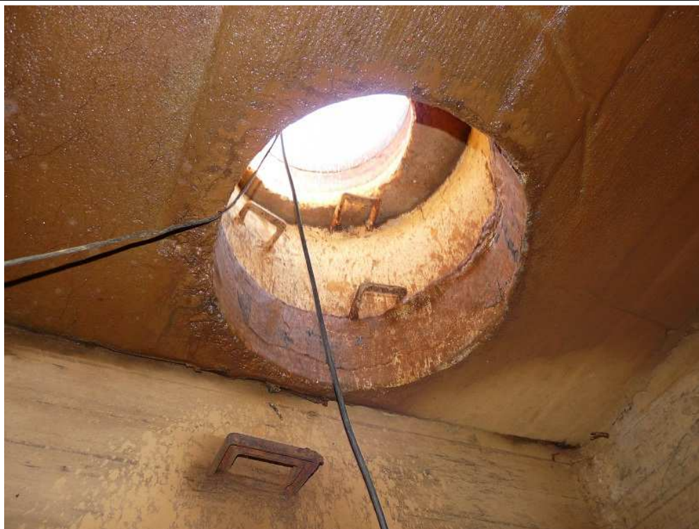
14. Komora nr2 - wejście do komory od strony południowej.
