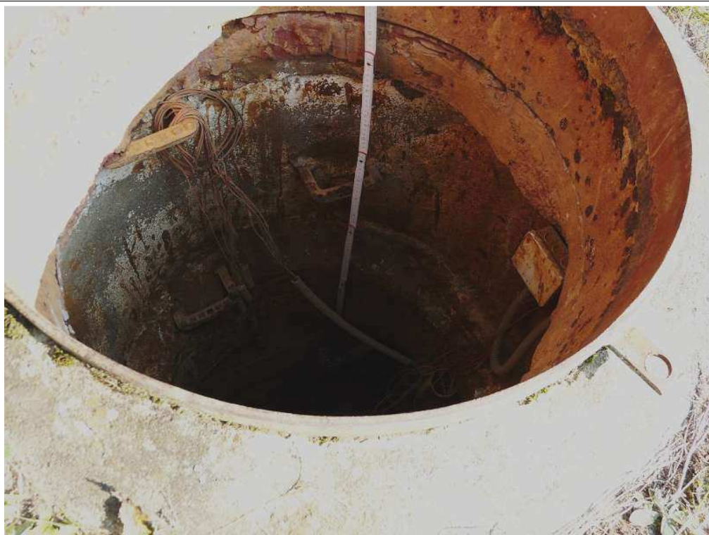
5. Kominiek wejściowy do komory nr2 - część górna.
