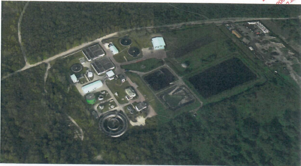
Fot.1. Oczyszczalnia ścieków Krym (źródło www.google.pl/maps )
