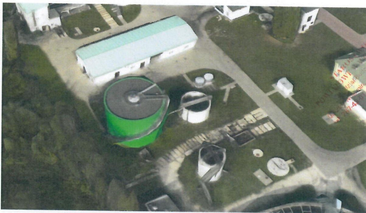
Fot.2. Oczyszczalnia ścieków Krym – rejon WKF i Maszynowni (źródło www.google.pl/maps )
