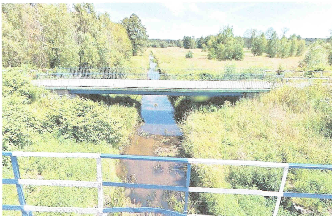
Widok w górę rzeki Czarna z mostu na drodze nr 635 (planowany przewiert nieco powyżej drugiego mostu ) Źródło: Google Earth
