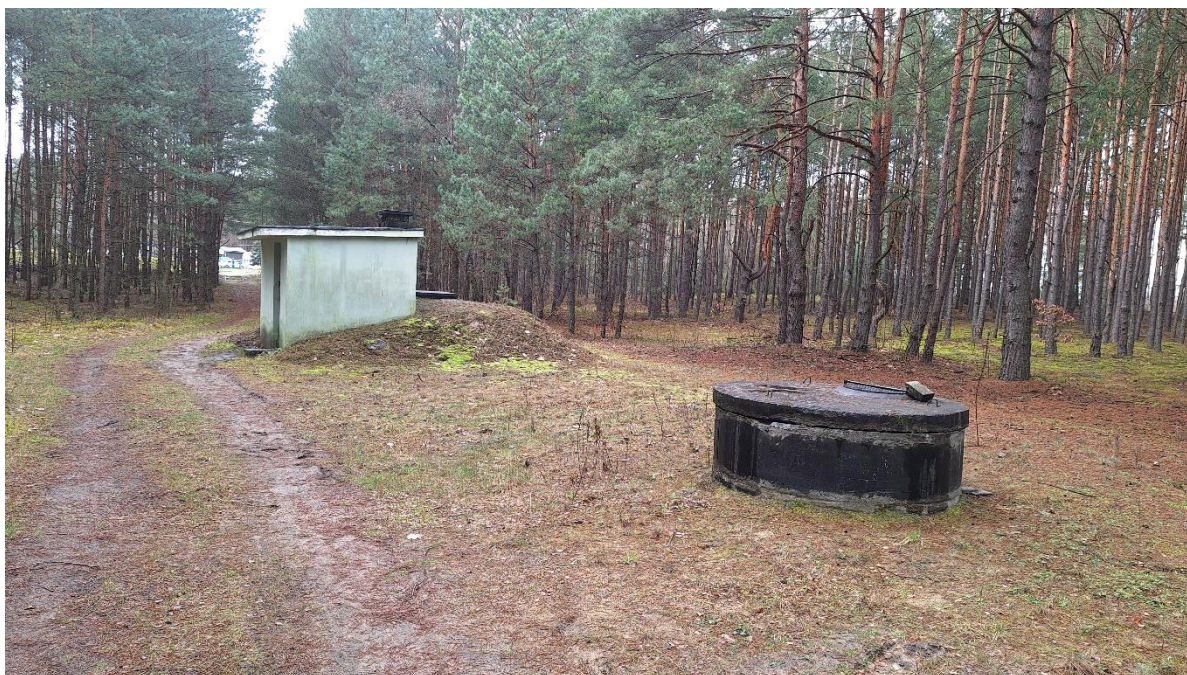
Rys. 6 Studnia nr IIA – widok stanu istniejącego
