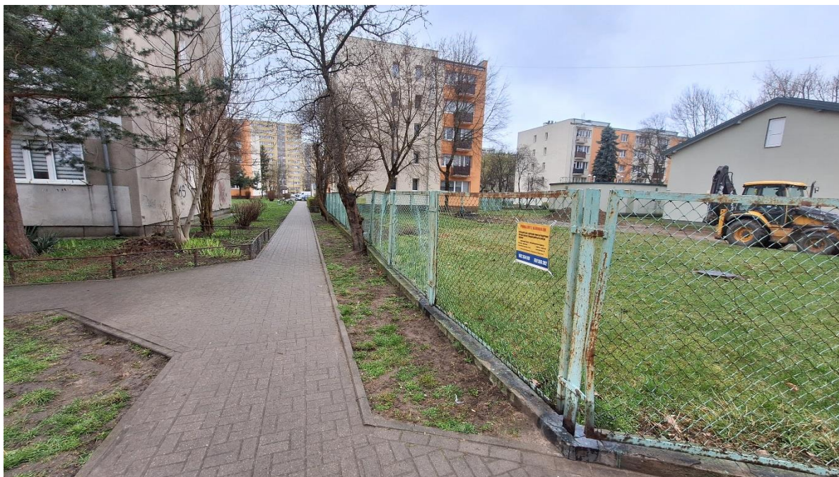
Rys. 14 SUW Lipińska – widok ogrodzenia istniejącego (przeznaczonego do rozbiórki), drzew przy ogrodzeniu oraz chodnika.
