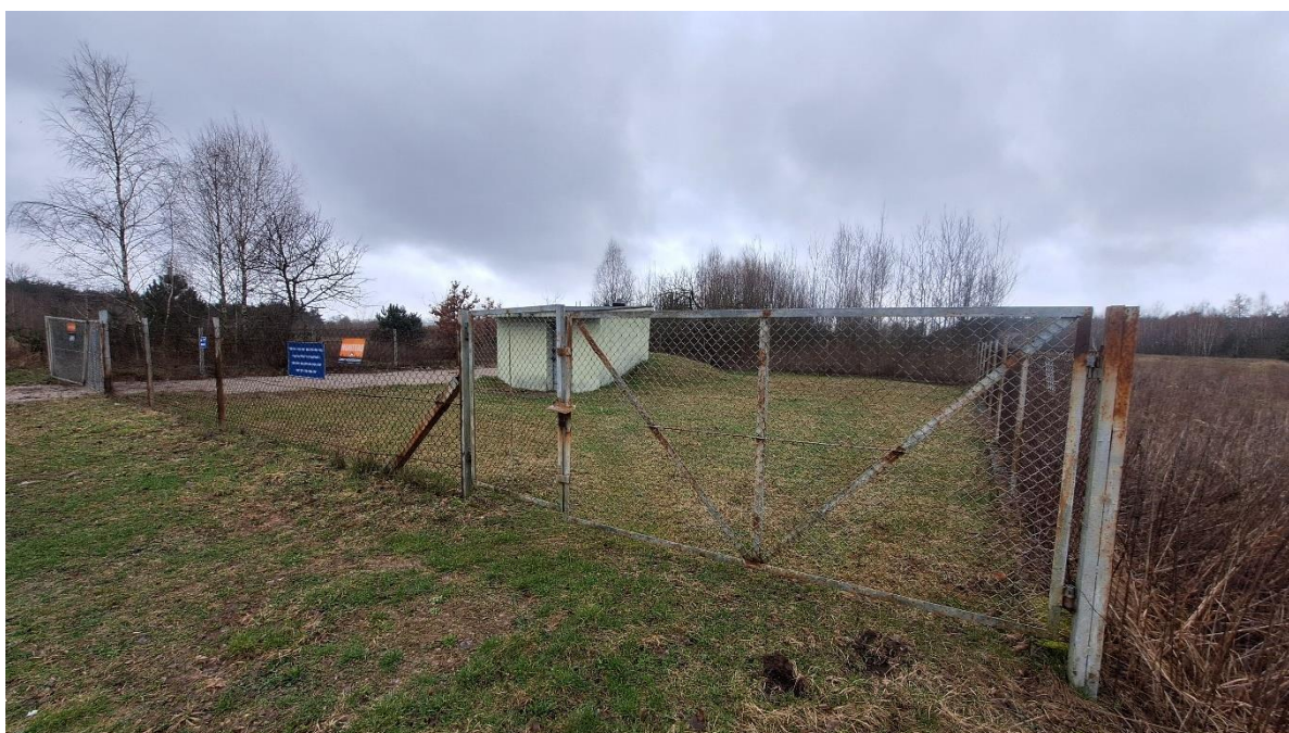
Rys. 7 Studnia nr III – widok ogrodzenia istniejącego (przeznaczonego do rozbiórki) od strony południowo – wschodniej.
