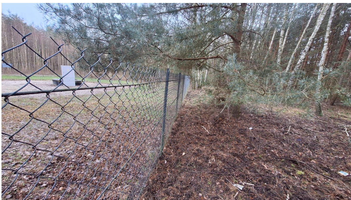
Rys. 5 Studnia nr IA – widok ogrodzenia istniejącego (przeznaczonego do rozbiórki) od strony południowo – zachodniej.
