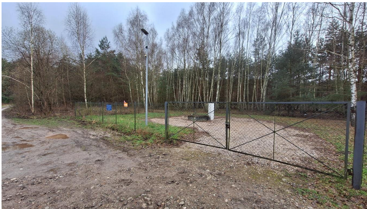
Rys. 4 Studnia nr IA – widok ogrodzenia istniejącego (przeznaczonego do rozbiórki) od strony północno – wschodniej.
