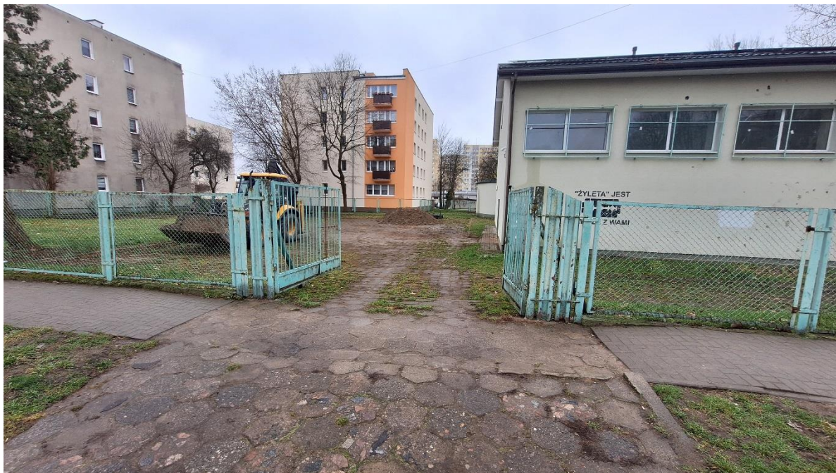
Rys. 12 SUW Lipińska – widok ogrodzenia istniejącego (przeznaczonego do rozbiórki) i chodnika.
