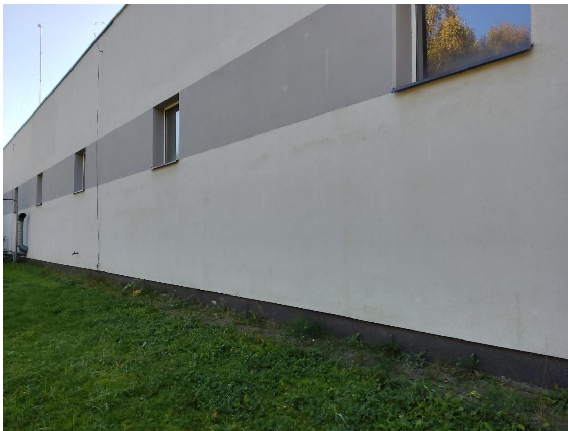
Rys. 9 Cokół pasa fundamentowego, odsadzka z betonowej kostki brukowej
