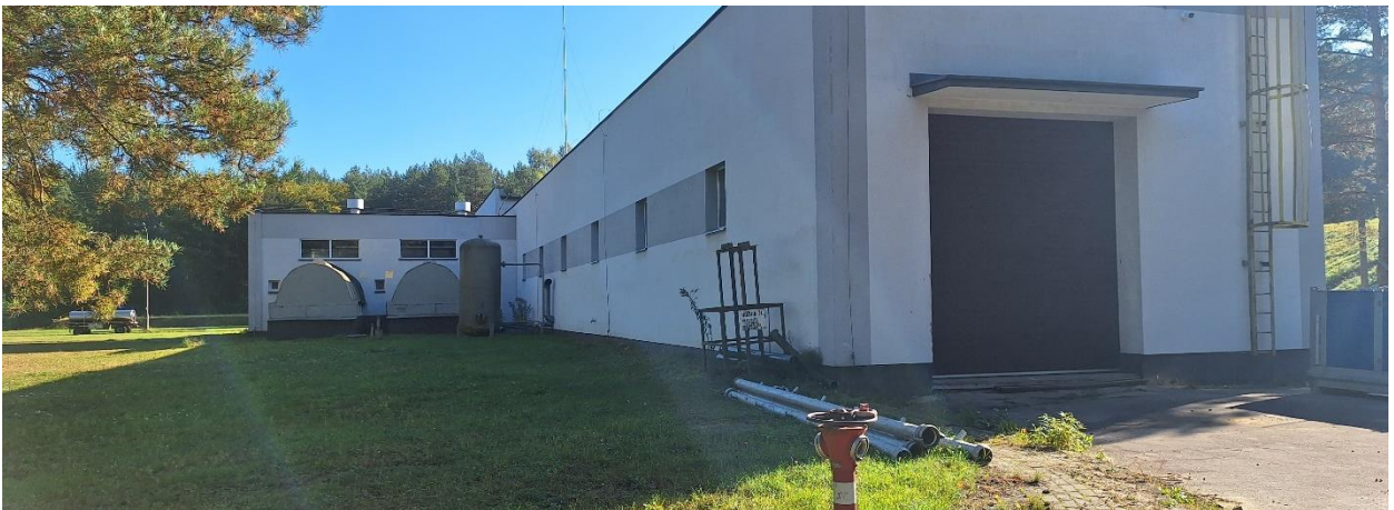
Rys. 3 Budynek hali pomp (elewacja zachodnia) – po prawej – hala filtrów
