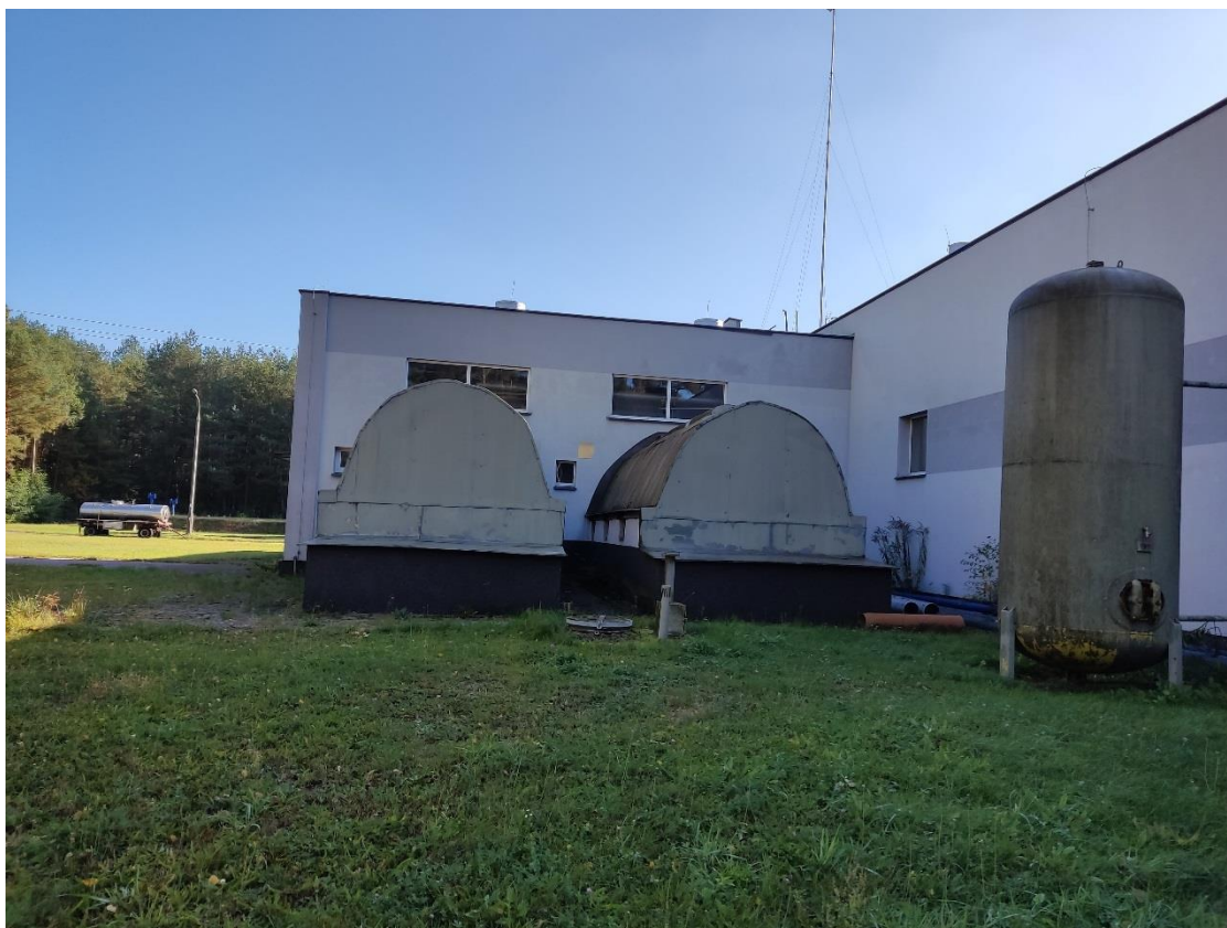
Rys. 10 Cokół pasa fundamentowego – strefa dodatkowych obiektów przy hali pomp
