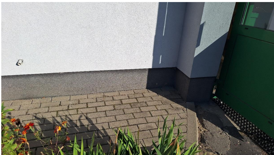
Rys. 6 Cokół pasa fundamentowego, odsadzka z betonowej kostki brukowej
