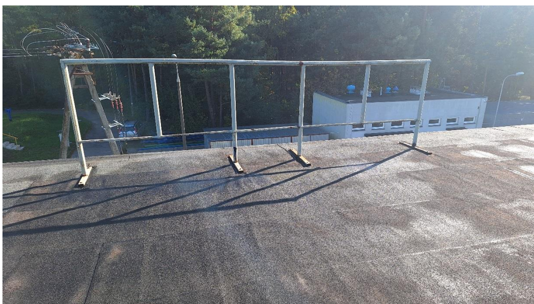
Rys. 16 Konstrukcja stalowa (wsporcza) – do demontażu
