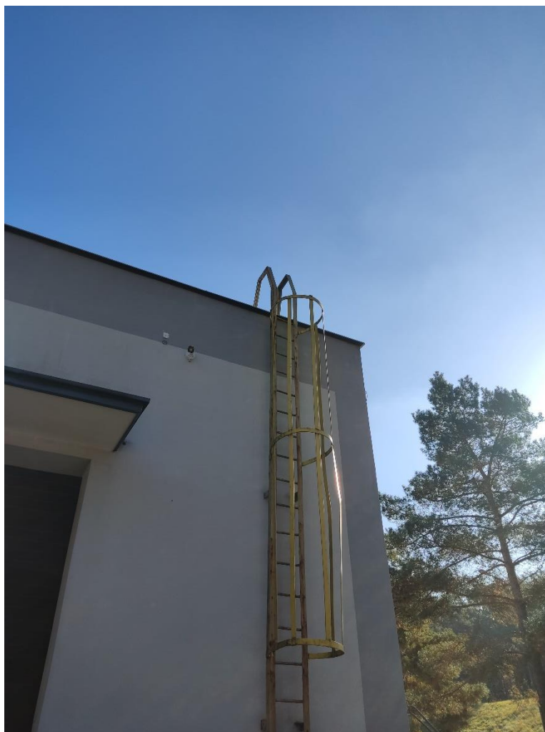
Rys. 10 Drabinka wyłazowa na dach – elewacja zachodnia
