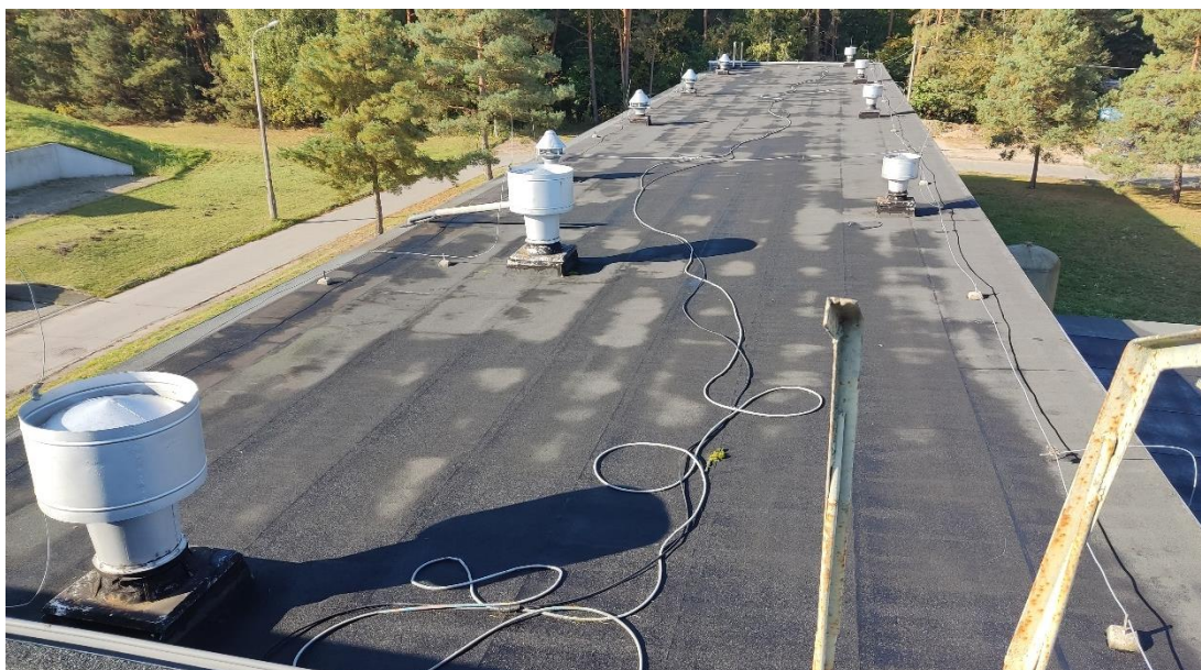
Rys. 6 Dach hali filtrów
