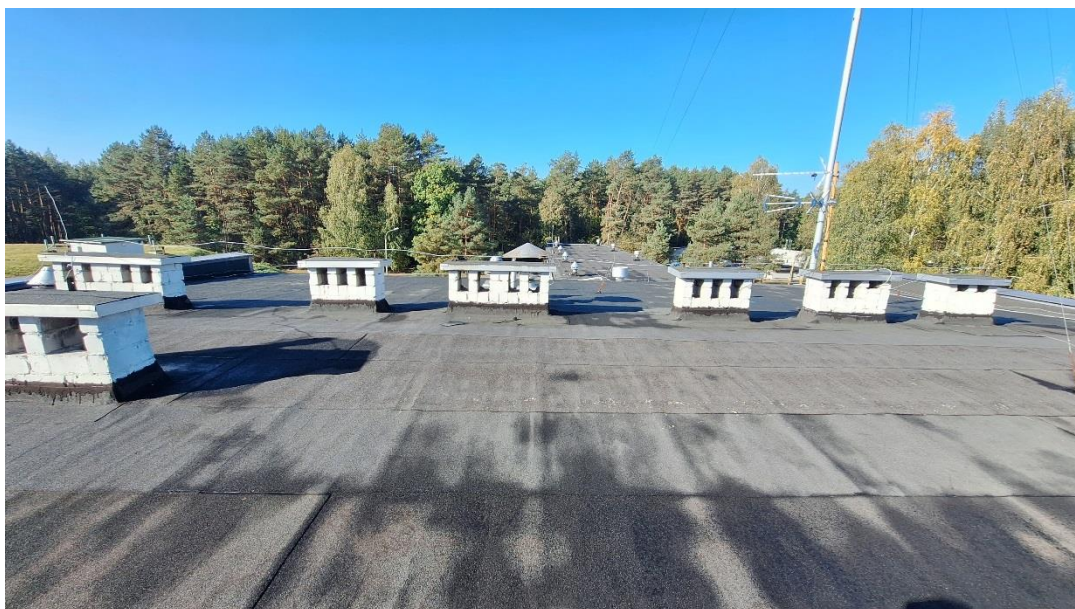
Rys. 15 Dach budynku – część energetyczna
