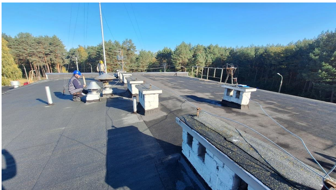
Rys. 13 Dach budynku – część energetyczna
