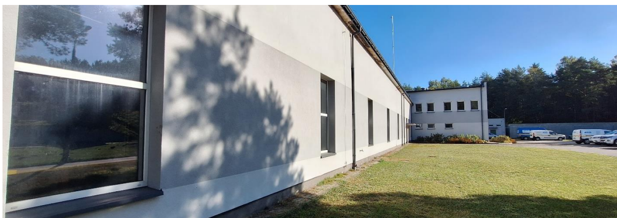
Rys. 2 Budynek hali filtrów (elewacja południowa) – dalej (po prawej) – część energetyczna
