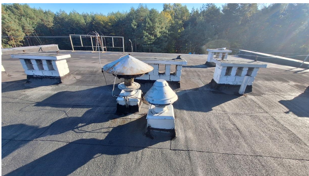
Rys. 14 Kominy murowane oraz kominki wentylacyjne
