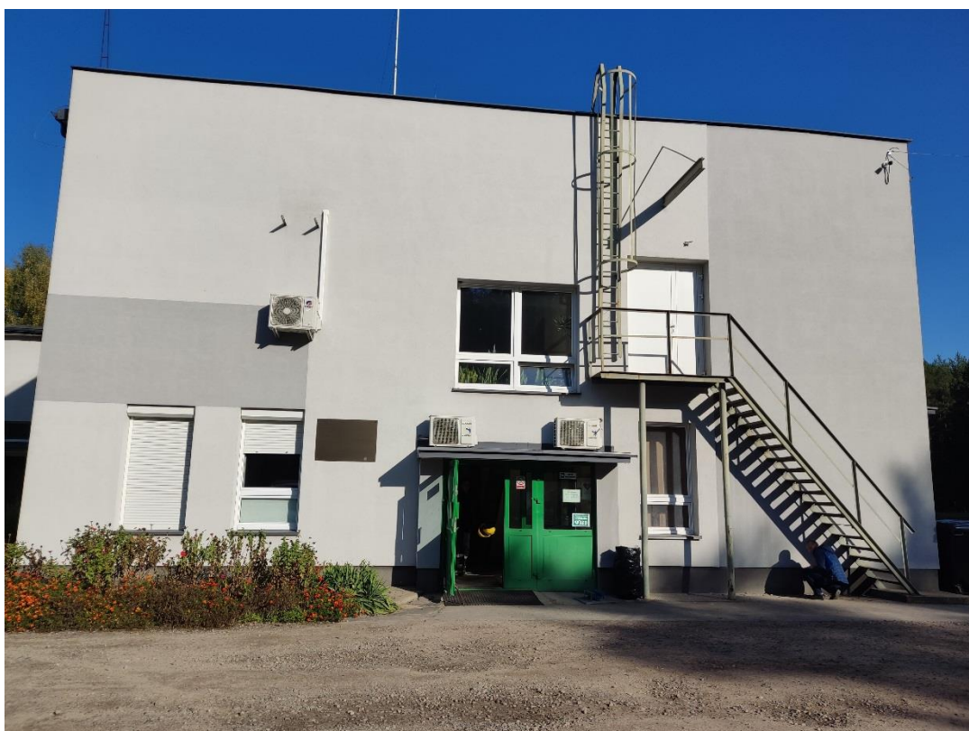
Rys. 18 Schody i drabinka stalowa – wejście na dach w części energetycznej
