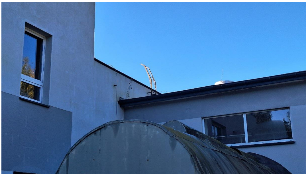
Rys. 12 Drabinka z dachu hali filtrów na dach hali pomp
